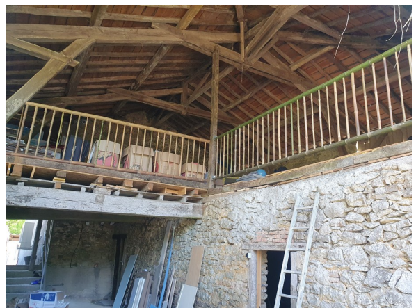
Garde corps en cannes de bambou
