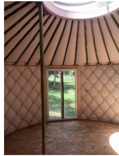
Structure porteuse en lamelles de bambou d'une yourte
